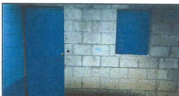
Foto 4: Sustitución de puerta
