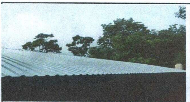
Foto 3: Sustitución de lámina
